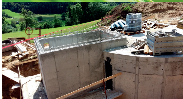
Izgradnja vodohrana v Šmartnem v Tuhinju s prostornino 100 m 3 .
