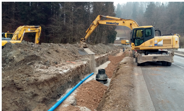
Gradnja vodovodnih cevi na odseku Kavran.
