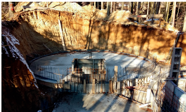
Gradnja vodohrana Soteska s kapaciteto 400 m 3 .
